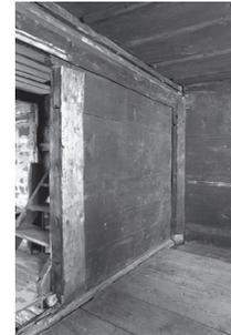
Abb. 305: Haus Oberplatz 14 (1423/34, mit Vorhalle) in Zug. Türpfosten im oberen Wohngeschoss. Die Türpfosten sind oben und unten gegabelt, die hier unten durchlaufenden Wandbohlen sind sekundär gekürzt.
