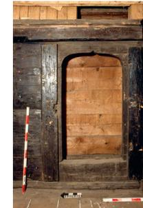
Abb. 308: Haus Lohlgasse 39/41 (1419/20) in Baar, oberes Wohngeschoss (1. OG), Raum über Stube. Tür in der gleichseitigen Aussentür. Die Tür ist von zwei Türpfosten flankiert. Oben und unten gegabelt und nehmen die durchlaufende obere und untere Wandbohle auf. Die obere Bohle, die auch den Türsturz bildet, ist mit einem Kollholz versetzt.
