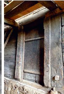
Abb. 307: Haus Hofstrasse 27 (1624/45) in Rüschikon am Rig (SEZ). Ausschnitt im unteren Wohngeschoss (EE). Die Tür ist dreifach neben einem Ständer eingepasst. Sie ist von zwei Türpfosten flankiert, wobei eine unmittelbar neben dem Ständer platziert ist.
